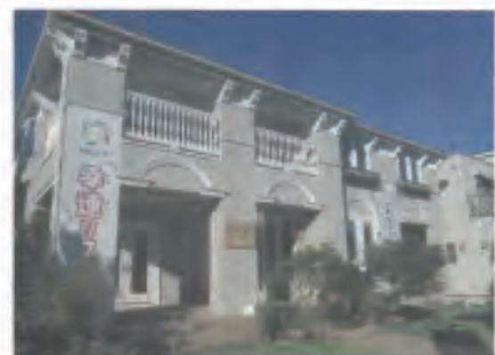
▲解体予定だったモデルハウスをリフォームして活用
