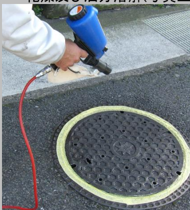
スリップ防止用 骨材塗布(写真上)
