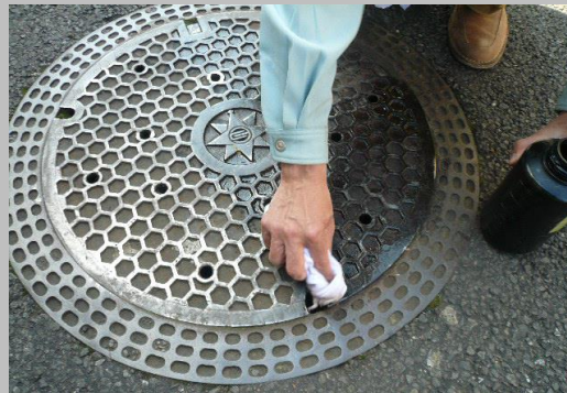
施工部の油脂除去(写真上)
